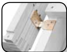
Монтаж на стропилах
