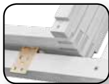
Монтаж на обрешетке
